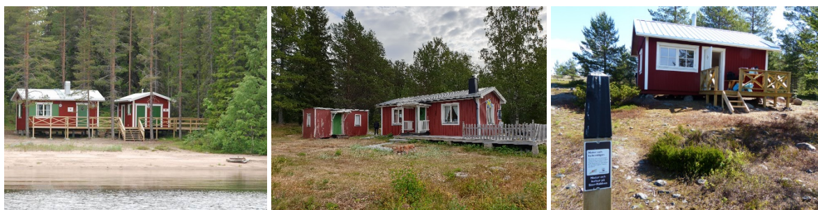
Figur 2 Exempel på uthyrningsstugor som byggts/rustats upp inom kommunsamverkansarbetet i olika projekt. Här stugor på Getskär/Renskär i Kalix skärgård, Mellerstön och Stor-Rebben i Piteå skärgård:
