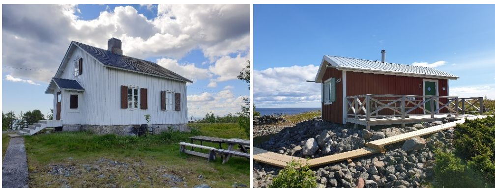
Figur 3. Exempel på uthyrningsstugor som byggts/rustats upp inom kommunsamverkansarbetet i olika projekt. Här stugor på Hamnskär samt Brändöskär i Skellefteå respektive Luleå skärgård.
